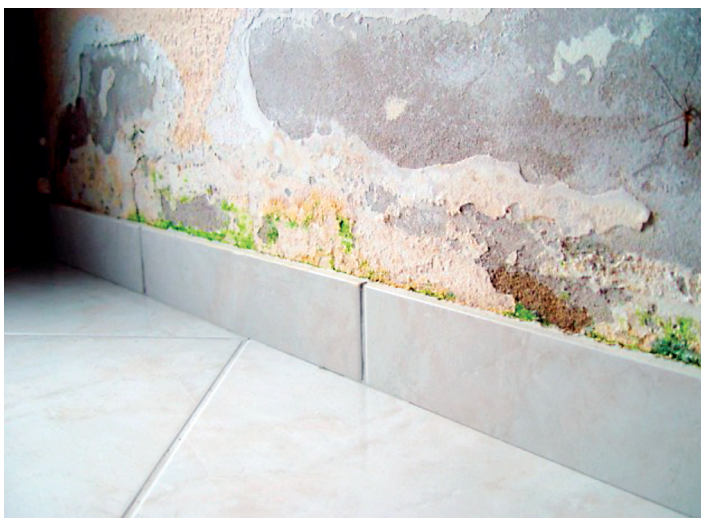
Aktiver Algenbefall in einem Raum, Ursache: Durchfeuchtung (Quelle: Schemmel Bremen)
